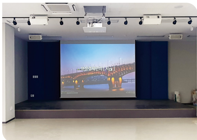
대회의실 영상 및 음향장비 시공
