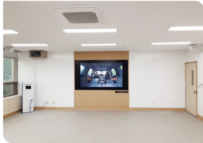
하이테크강의실 리모델링 공사
