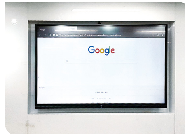
매립형 전자칠판 설치
