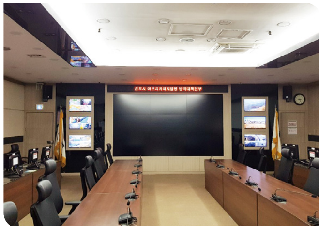
시청 화상회의장비시스템 설치
